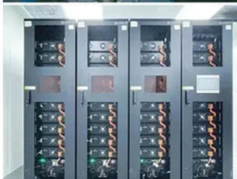
مرکز پزشکی شرقی کونشان: ذخیره انرژی پشتیبان اتاق های عمل و مناطق همودیالیز
